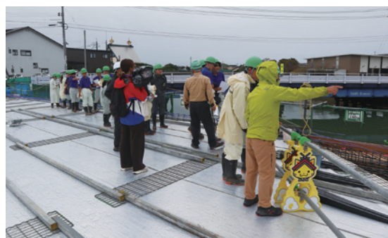
工事現場に入って説明を受けている様子
